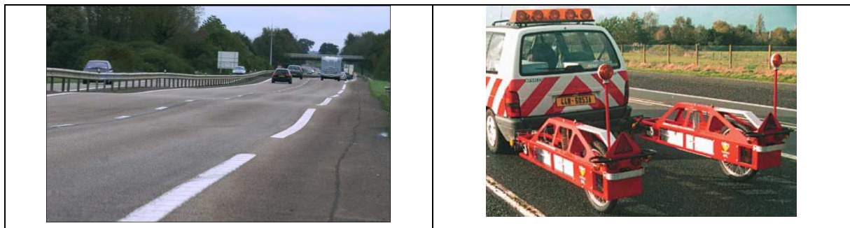
Figure 1. Chaussée présentant un défaut d'uni longitudinal et appareil d'auscultation dédié à la mesure de ce défaut (APL)
