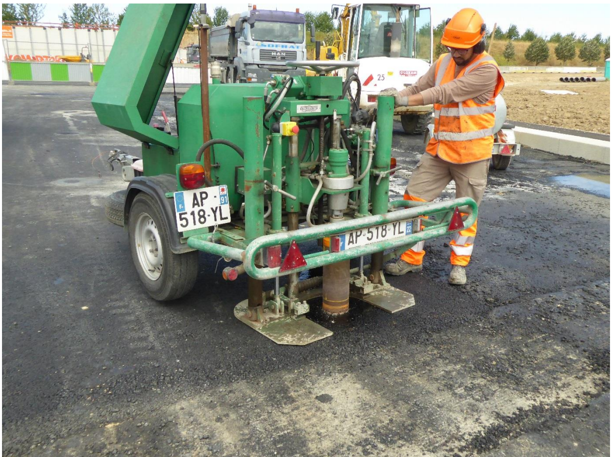
Figure 17. Carottier de chantier
