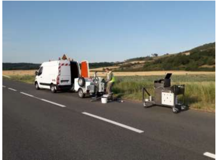
Figure 6 : Installation du matériel sur site
