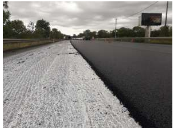
Figure 11 : Structure BBSG sur chaussée rabotée
