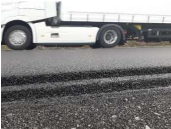
Figure 10 : Structure BBSG sur GB
