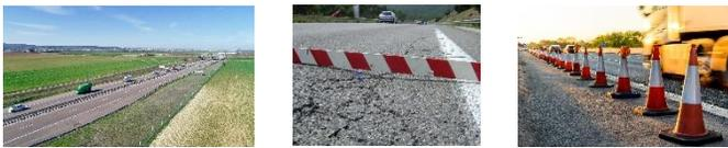
**Matériau** : BBSG 0/10mm (classe 2), bitume 50/70, %vides visé 8%
