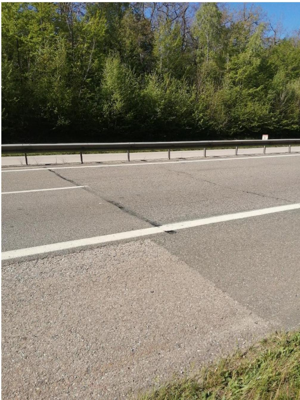
Figure 28 : Exemple de démarcation visuelle entre 2 planches (ici planche de début de travaux 3E+R) et en arrière-plan le panneau PR 31+000 qui a servi à recalibrer les données.
